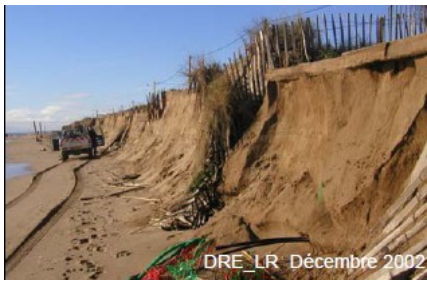
Phénomène d'érosion du cordon dunaire lors de la tempête de décembre 2002
