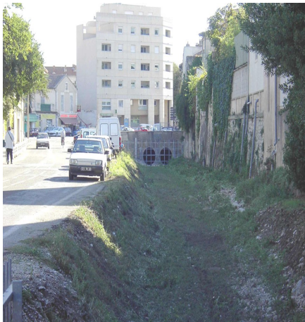
Figure 6 : Entrée en souterrain du cadereau d'Alès
