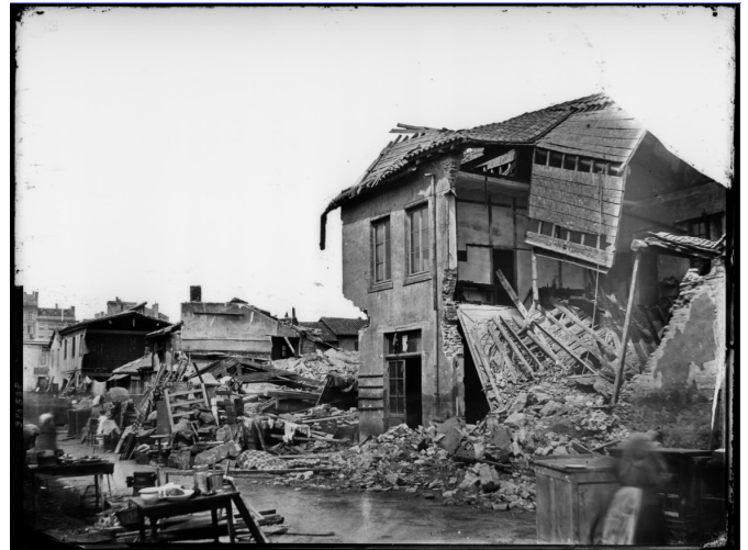
Inondation du Rhône, à Lyon : dégâts : rue Madame (actuellement rue P. Corneille), 9 juin 1856 / cliché Louis Froissart] – Archives municipales de Lyon
