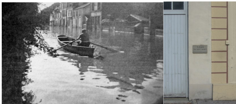
Figure 4 : Louhans ; rue des Bordes et repère de crue, 04/10/1935 (source : DREAL Bourgogne et DDT Jura)
