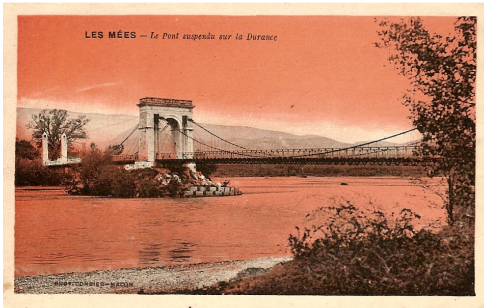
Figure 2 : Deuxième Pont des Mées rebâti de 1854 à 1857 après la destruction du premier pont lors de la crue de novembre 1843 (Source : www.art-et-histoire.com )
