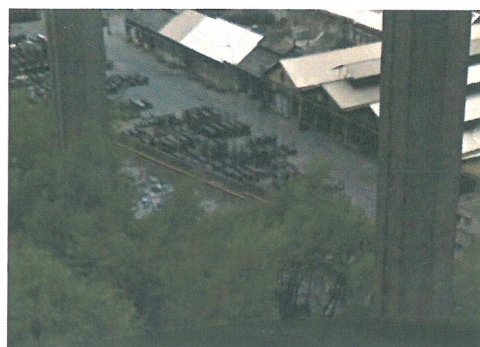
Mur de l'usine en rive droite à Passy
