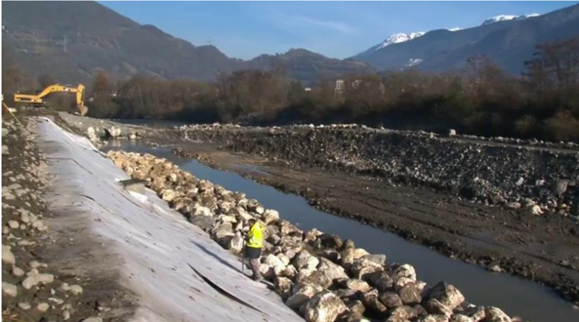
Figure 15 : Travaux d'enrochements menés dans le cadre de la tranche I du projet Isère amont (crédit photo : SYMBHI)
