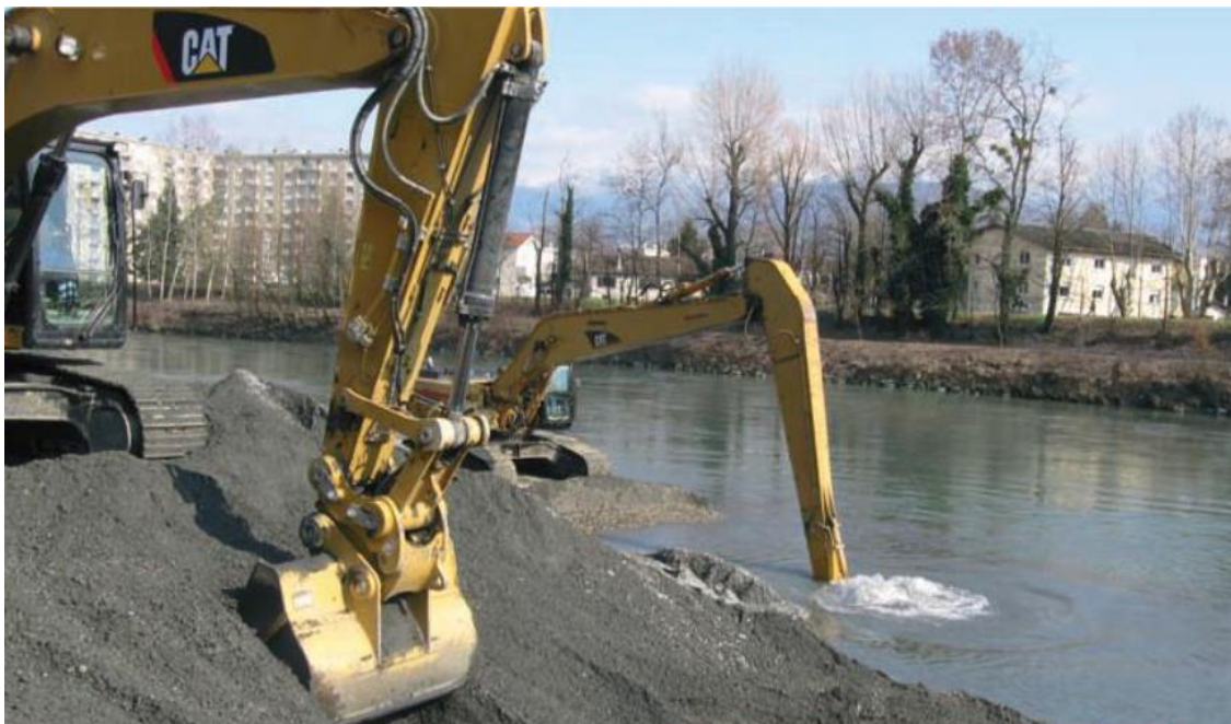
Figure 16 : Curage des bancs dans la forêt des Sablons à la Tronche (crédit photo : SYMBHI)
