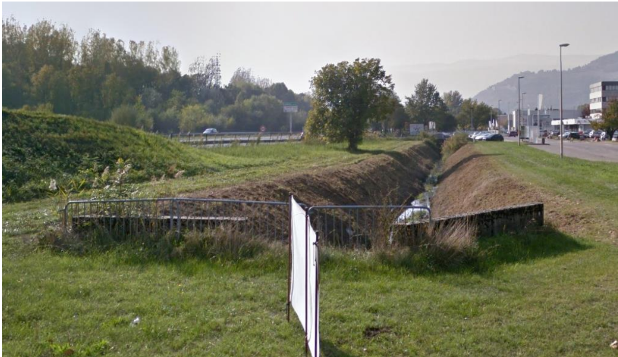
Figure 3 : Chantourne de la Tronche avant son entrée en souterrain (source : Google StreetView ©)
