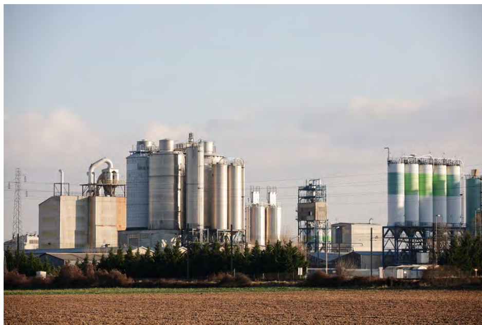
Photo 10: installation classée au titre de la protection de l'environnement - AII (©D. Palanque)
