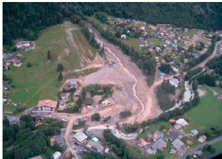
Vue aérienne de la lave du nant d'Armanette sur le cône de déjection dans le secteur de Cugnon (source : RTM74)
