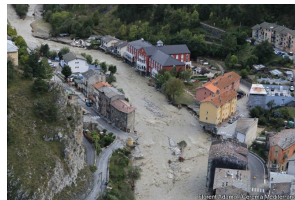
Breil-sur-Roya en octobre 2020 (source : CEREMA Méditerranée)
