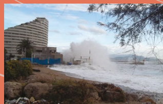
Tempête à Villeneuve-Loubet (06) novembre 2011 - Crédit : DDTM06
