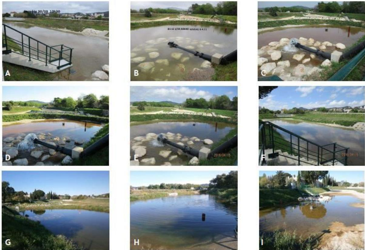
Figure 9 - Planche photo du bassin d'infiltration en fonctionnement lors des essais de qualification en 2015
