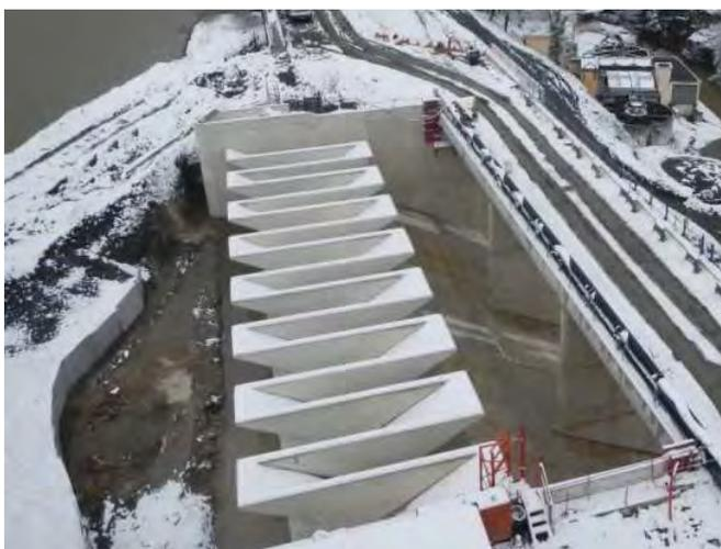
**Figure 8 : pkw – barrage de Rassisse (maître d'œuvre ISL 2014-2015)**
