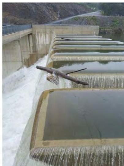
Figure 3 : Evacuateur du Barrage de Rassisse en fonctionnement (maîtrise d'œuvre ISL)
