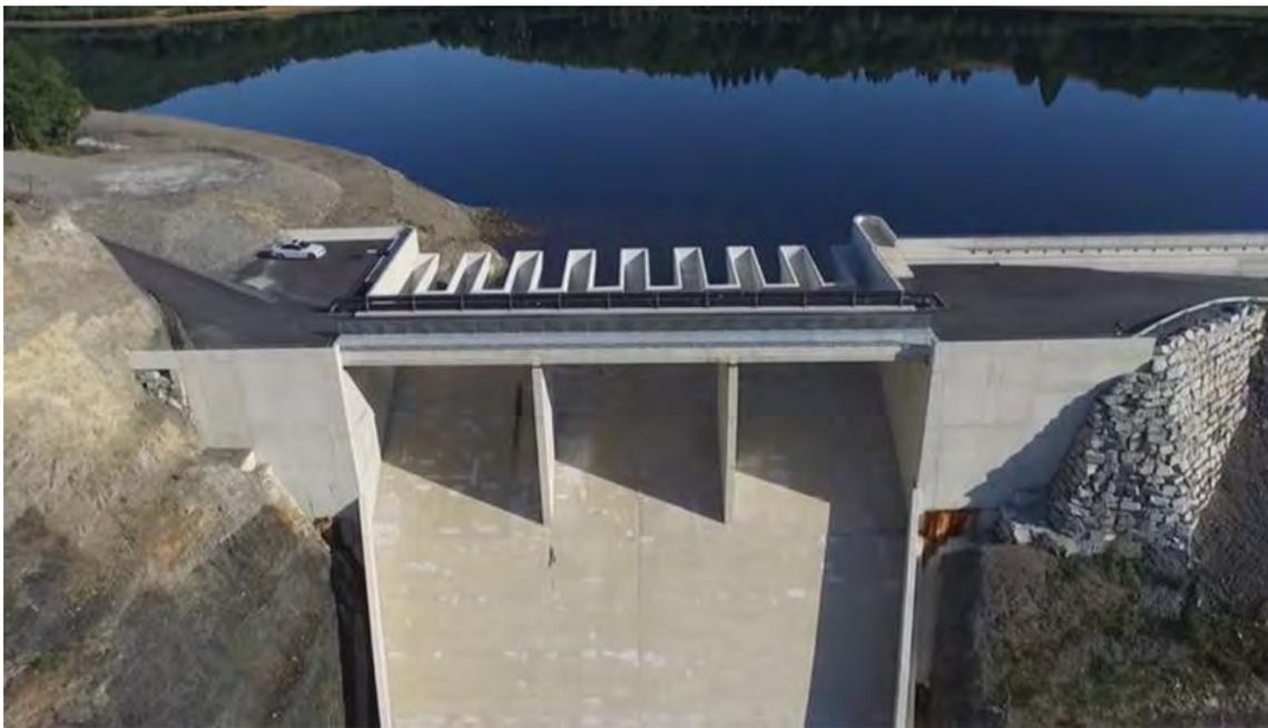
Figure 2 : Evacuateur de crues type PK weir du barrage de Rassisse (maîtrise d'œuvre ISL)
