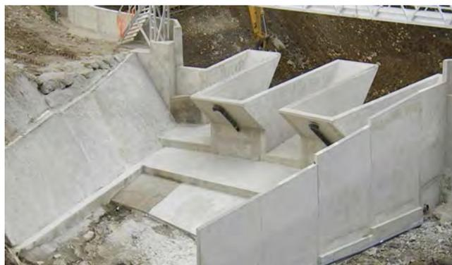
**Figure 9 : PKW – barrage des Gloriettes (maître d'œuvre EDF 2011-2012)**
