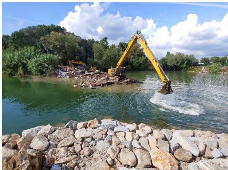
Figure 22 : Suppression du seuil du moulin des Iscles en 2020.
