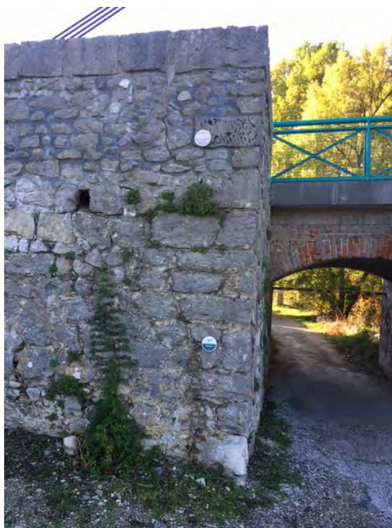
Repères de crue sur le pont suspendu de Saint Bauzille de Putois – photo EPTB FH
