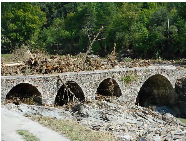
Pont après la crue de septembre 2020 – Haut Hérault- photo EPTB FH
