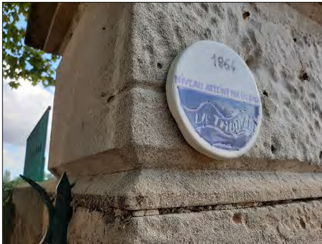
Crue d'octobre 2019 : laisse de crue juste sous le repère de 1964 sur la Thongue à Montblanc et dégâts à l'aval immédiat de Servian sur la Lène – photos EPTB FH
