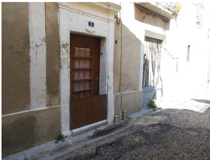
Exemple de batardeau – photo EPTB FH
