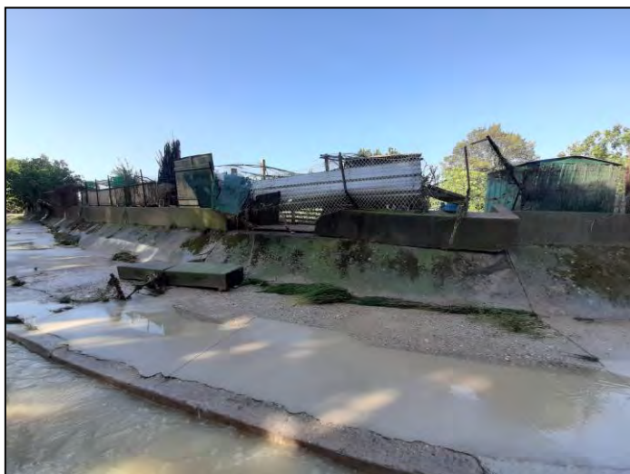
Servian le 23/10/19 – mur endommagé sur la digue de la Lène
