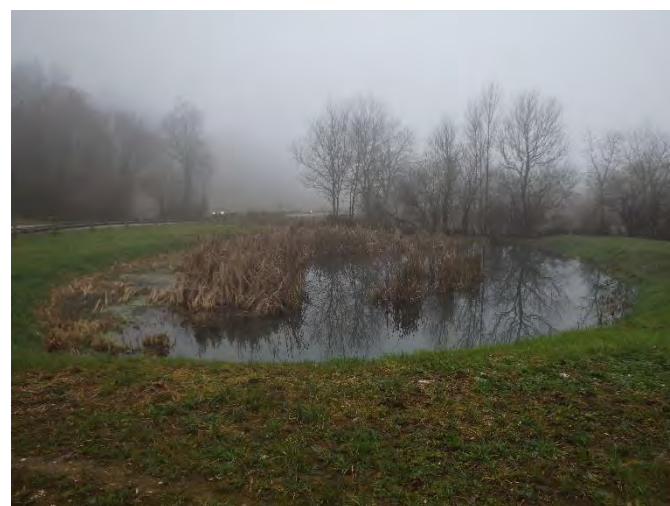
Figure 25 : Bassins de rétention du Flon (vue bassin aval)
