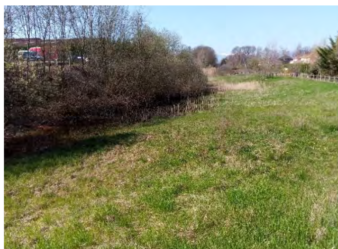
Figure 23 : Bassin de rétention de Magny
