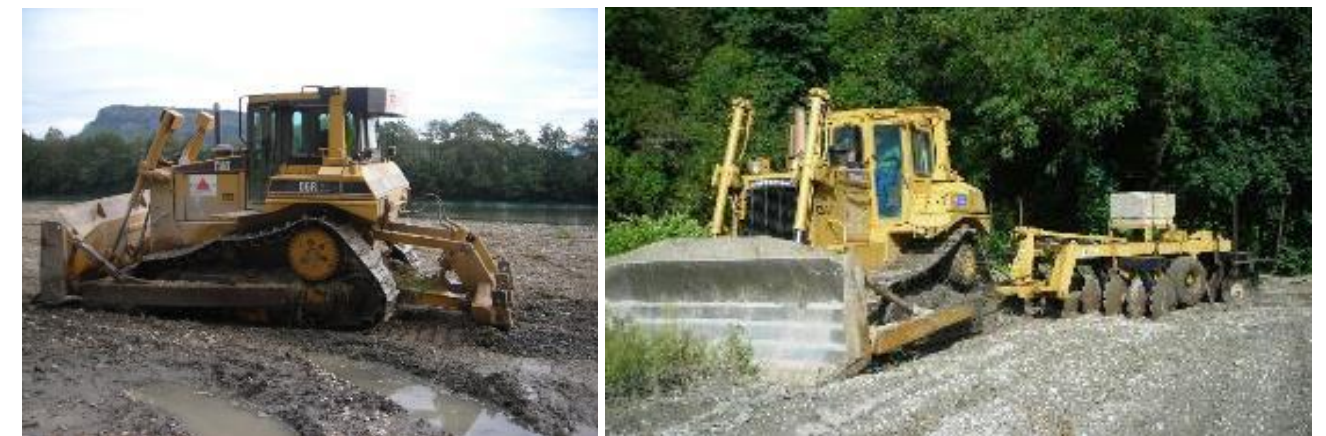
Figure 5 : Charruage des bancs de graviers d'un lit mineur d'un Vieux Rhône (document interne CNR, 2018)
