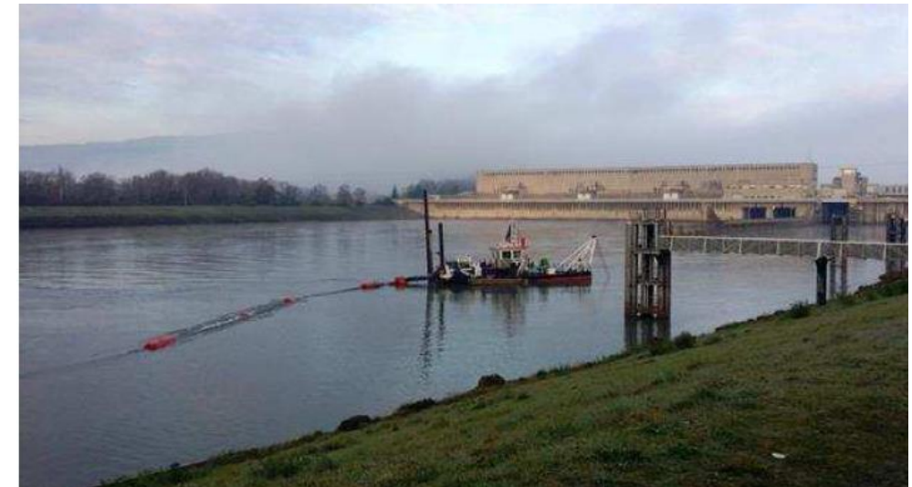
Dragage du garage aval de l'écluse de Bourg-lès-Valence (EDF-CNR, 2018)
