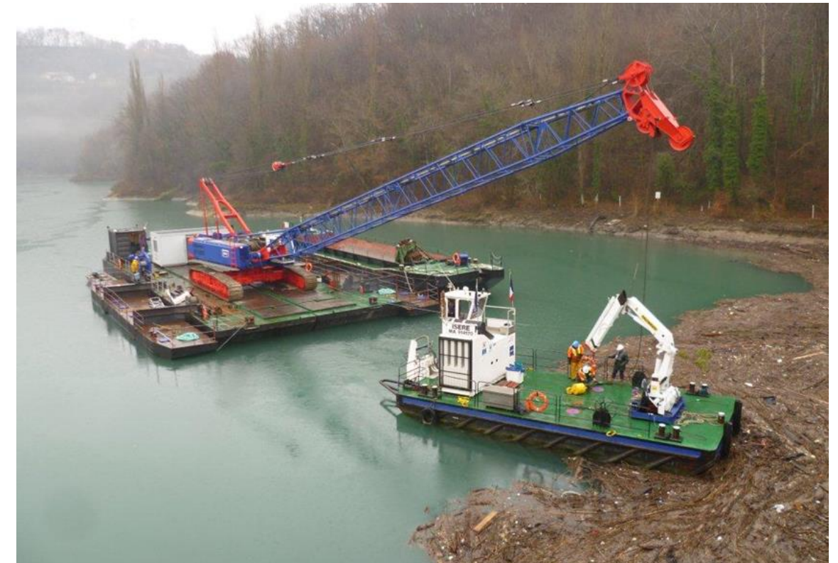
Dragage du parement amont du barrage de Génissiat (CNR, 2013 ; in EKIUM, 2014)
