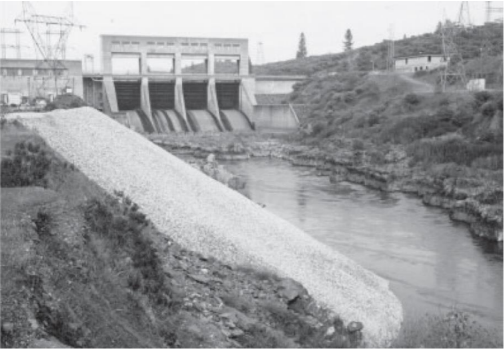
Figure 51 : Réinjection de graviers via un stockage remobilisable à haut débit sur le Sacramento, en aval du barrage de Keswick, California (Kondolf et al., 2014)
