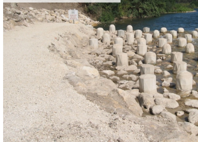
Piste d'accès mécanisé
