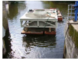
La barge entre dans l'emplacement
