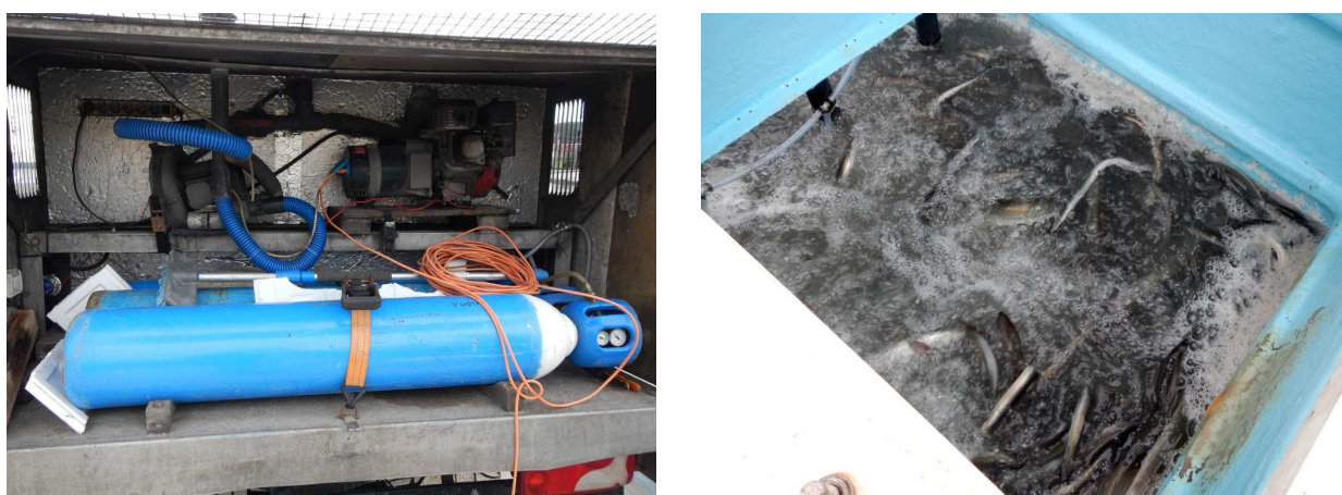
Figure 3 : Système d'aération (pompes à air) et d'injection d'oxygène pur (bouteilles d'oxygène comprimé).
