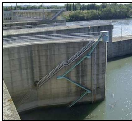
**Figures 16 et 17: passes-pièges situées en rive gauche (16) et rive droite (17) (MRM)**
