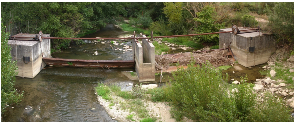
Figure 29 : Barrage de Pont de La Chaux (Août 2011)
