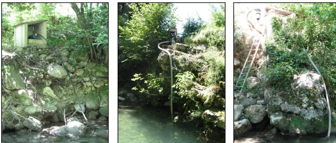
Figure 11 : Pompes agricoles/domestiques observées entre Vence Poutaouchoun et Saint-Jeannet
