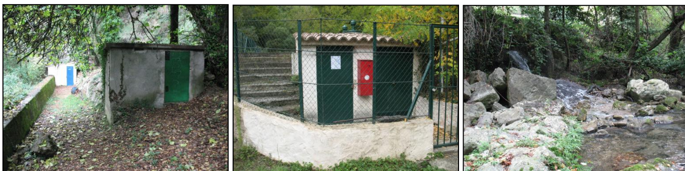
Figure 2 : Captages des sources Féraud et Meynier en rive gauche de la Cagne, poste de chloration et surverse
