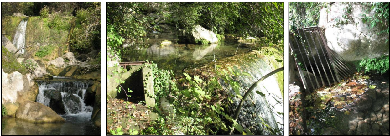
Figure 10 : Prise d'eau de l'ancienne pisciculture
