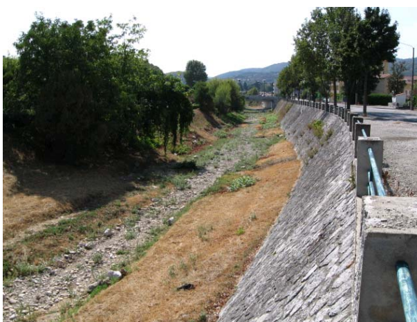
Figure 4 : Lit du Mialan en août 2009
