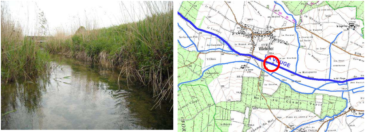
Figure 21 : Présentation et localisation de la station DMB : la Vouge à Villebichot
