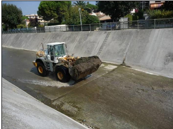
Au mois d'octobre 2011, les travaux de curage ont été réalisés sur la partie basse de la Cagne, les espèces piscicoles présentes n'ont pas été prises en compte, aucune pêche électrique de sauvetage n'a été réalisée. De plus, une fois les travaux finis, seule une fine lame d'eau s'écoulait sur du béton brut, ne laissant aucun couloir de montaison disponible aux civelles.
