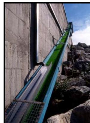
Quel que soit le système de franchissement (goulotte, passe-piège, etc.), les passes à anguilles présentent toutes le même principe de base, à savoir la mise en place de zones humides favorables à la reptation. Elles sont ainsi composées de deux parties : la rampe de montée et la partie amont.
