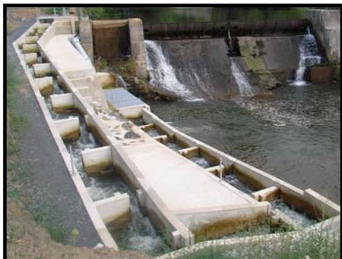
Les passes à bassins successifs (fig.13) sont le dispositif de franchissement le plus utilisé. Le principe consiste à diviser la hauteur totale de l'obstacle en plusieurs petites chutes formant une série de bassins. Les principaux paramètres sont les dimensions des bassins et les caractéristiques géométriques des cloisons qui les séparent (dimension et position des déversoirs, fentes et orifices).
