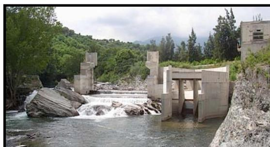
**Figure 73 : Seuil de la microcentrale de Lucciana Olmo sur le Golo (MRM)**
