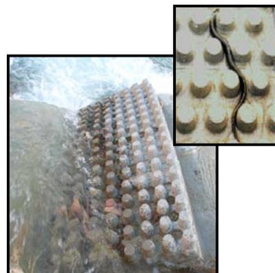
**Figure 18 : Dalles à plots bétons sur le Vidourle (MRM)**
