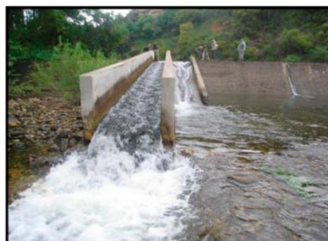
**Figure 12 : passe à ralentisseurs (seuil de la Voulte sur le Jaur) (MRM)**
