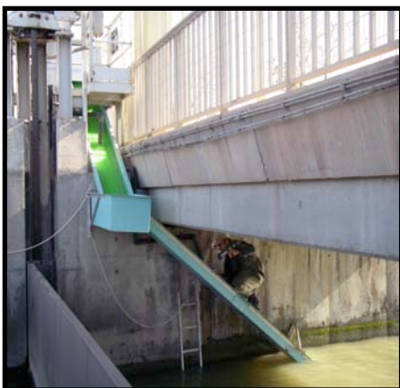
Figure 15 : Passe piège à anguilles du barrage anti-sel lors de son entretien (MRM)
