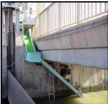
Figure 16 : Passe piège à anguilles du barrage anti-sel lors de son entretien (MRM)
