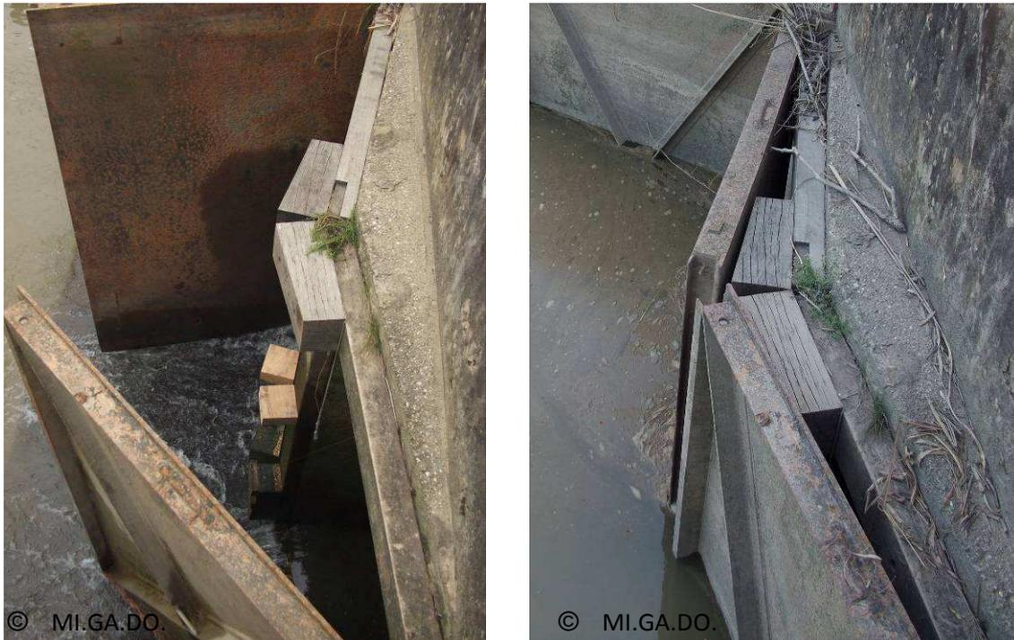
**Figure 21 : Mise en place des cales en chêne au niveau des portes à flot d’Arcins, à marée basse (portes à flot ouvertes) et à marée montante (portes à flot fermées laissant une ouverture de 10cm sur toute la hauteur). Source : MI.GA.DO., 2009**
