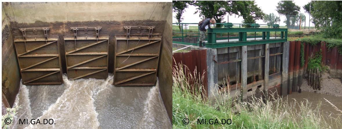
**Figure 30 : Système de clapets à axe horizontal sur le marais de Lafite. Source : MI.GA.DO., 2008.**
