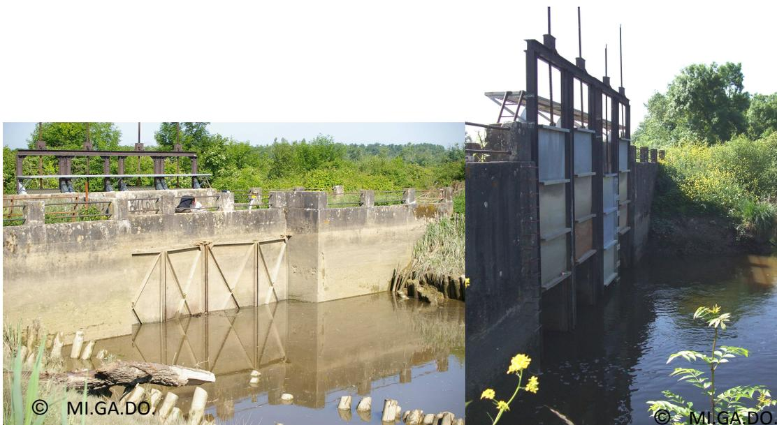
**Figure 19 : Portes à flot du marais d’Arcins en position fermée à marée haute et vannes associées. Source : MI.GA.DO., 2009**
