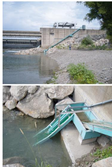
**Figure 12 : Passe-piège du barrage EDF de Mallemort avant (gauche) et après (droite) travaux ( MRM / EDF)**
