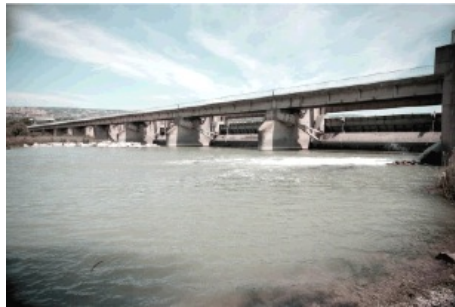
Figure 8 : Barrage EDF de Mallemort (© MRM / F. Gardin. 2007)
