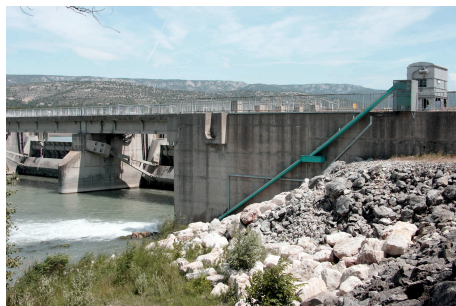
Figure 9 : Passe-piège du barrage EDF de Mallemort (© MRM / F. Gardin. 2007)
