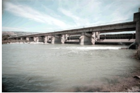
Figure 10 : Barrage EDF de Mallemort (© MRM / F. Gardin. 2007)
