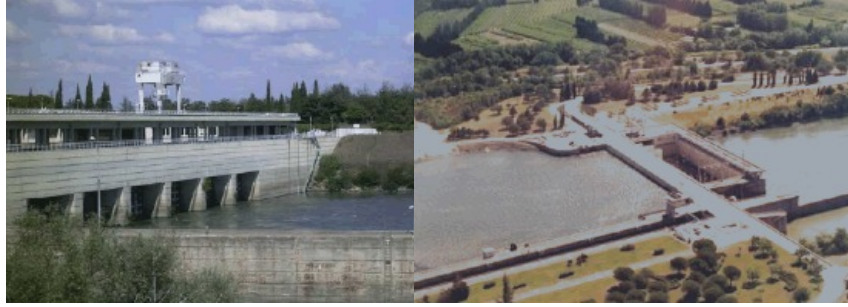
Figure 4 : Aménagement hydro-électrique de Beaucaire-Vallabrègues
