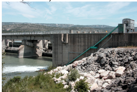
Figure 11 : Passe-piège du barrage EDF de Mallemort (© MRM / F. Gardin. 2007)
