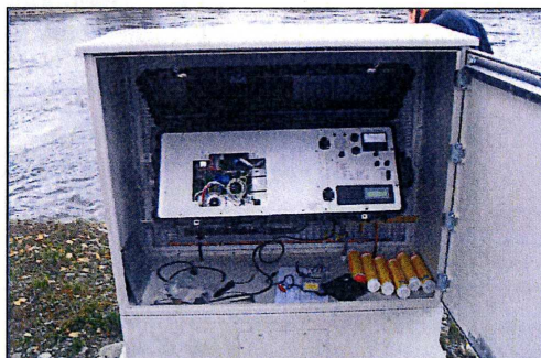
Station NEDAP sur site (photo EDF)
