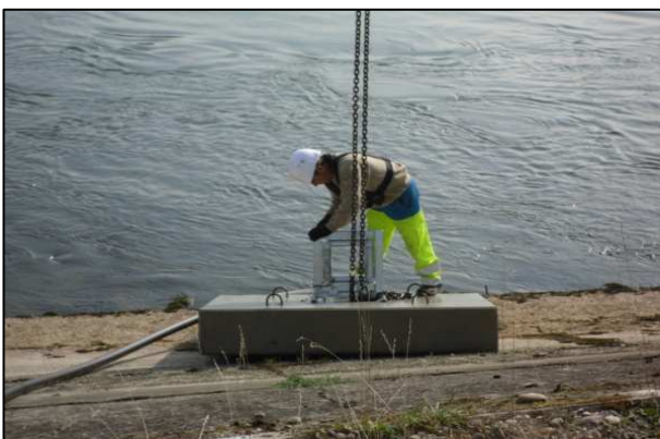
Préparation d'un guide câble
