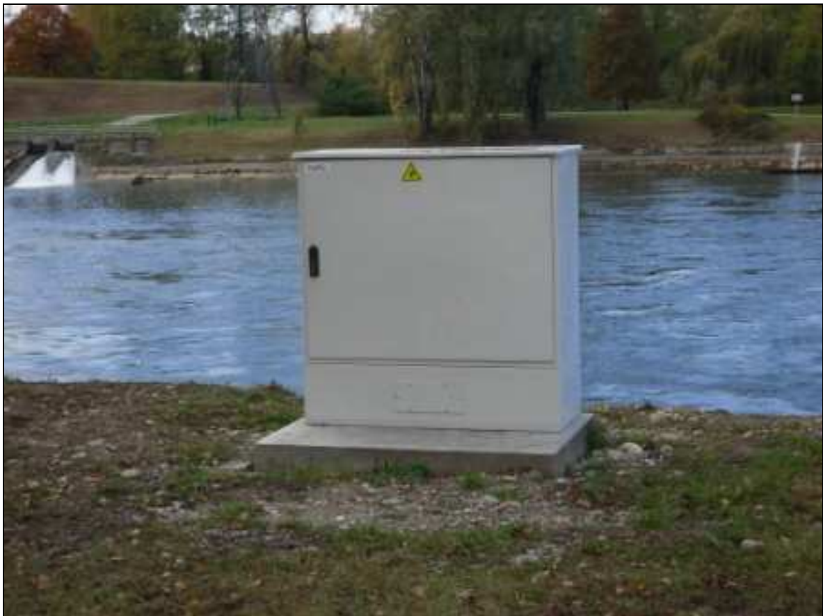
Illustration Vue d'une armoire contenant une station d'enregistrement NEDAP
