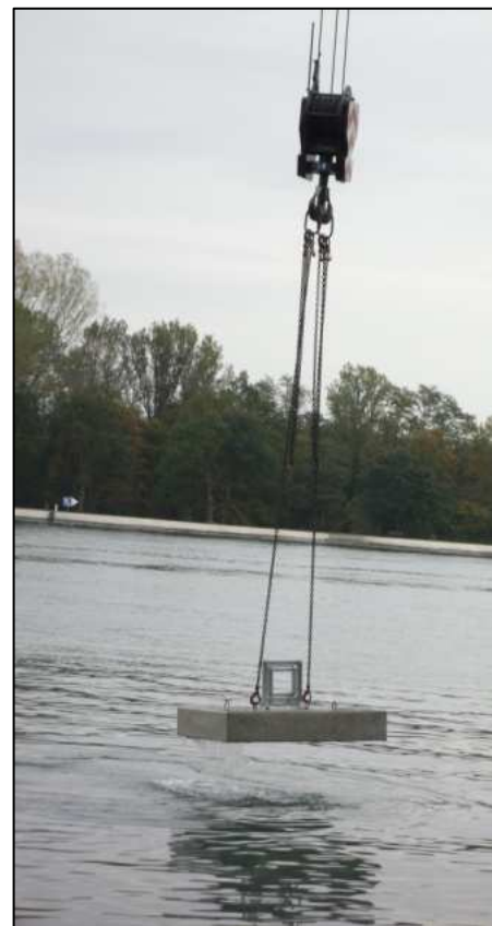
Grue pour levage et immersion des guides câbles
