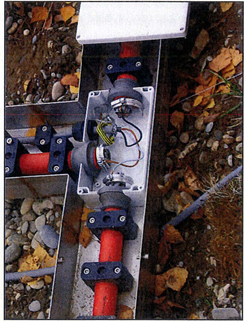
Illustration du système de raccord en T permettant de relier les 3 câbles-antennes à la station NEDAP
