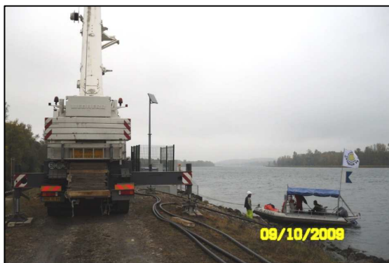
Grue pour levage et immersion des guides câbles
