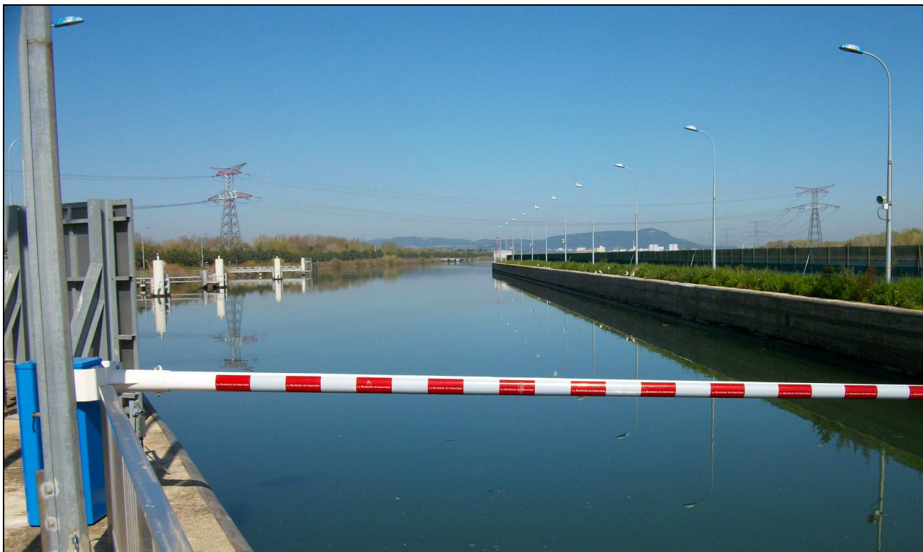
Vue de la partie amont de l'écluse de Caderousse
