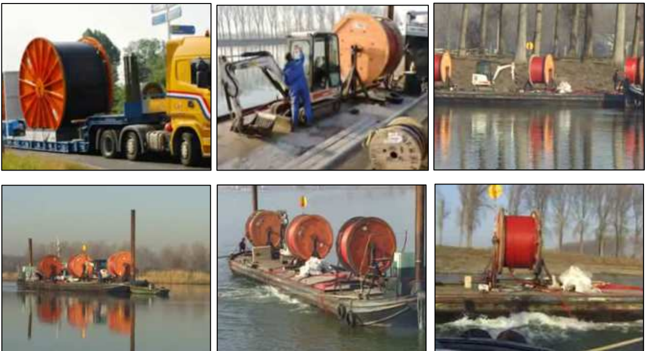
Illustration de la pose des câbles par voie fluviale (source NEDAP)
