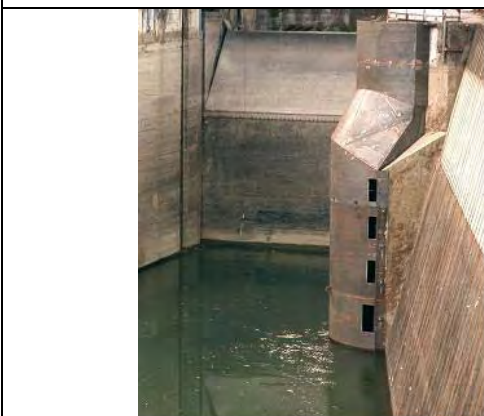
Détail de l'exutoire profond à niveau bas. On distingue les orifices latéraux. L'entrée principale est située dans le bas du cylindre (- 7m)
