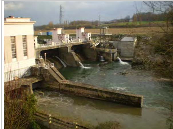
Usine de Baigts (à gauche) et barrage (à droite) vus de l'aval en l'absence de déversement
