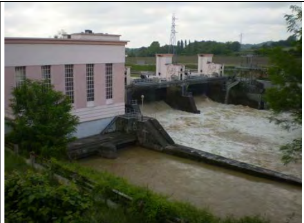
Usine lors d'un déversement par les vannes de crue
