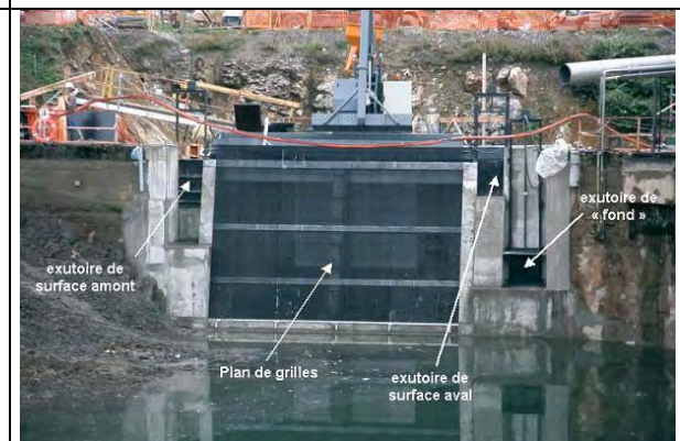
Prise d'eau de la micro-centrale en rive gauche avant sa mise en eau. On distingue les deux exutoires de surface et l'exutoire de fond
