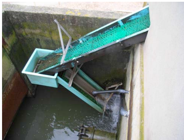
Figure 8 : Schéma Passe-piège à Anguille situé entre l'étang et le canal d'Arles à Fos (MRM)
