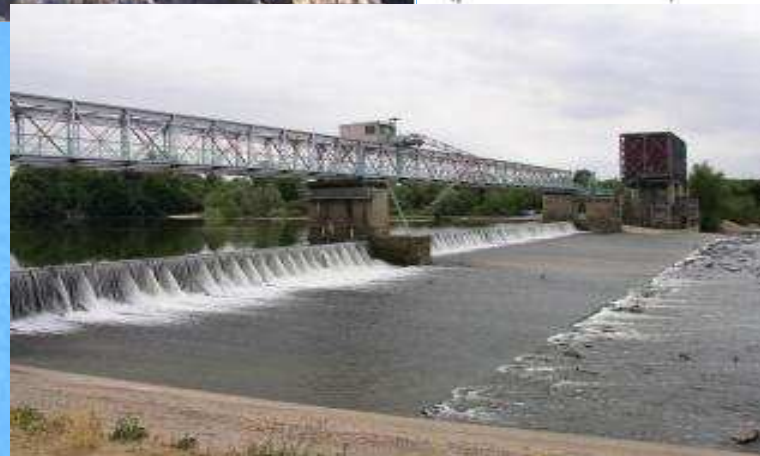
Seuil en enrochements de Bea (photo D. BARIL, CSP).
