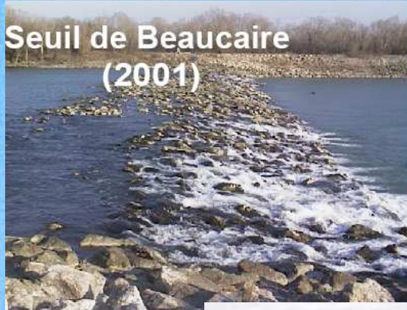
Seuil en enrochements de Bea (photo D. BARIL, CSP).
