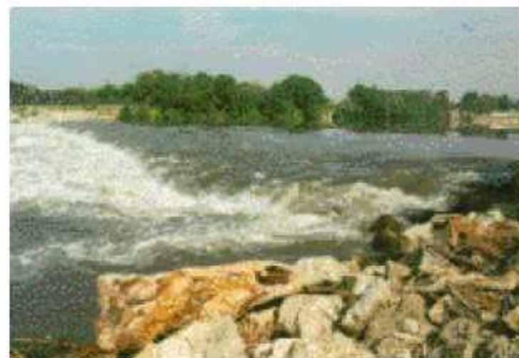
Seuil en enrochements de Bea (photo D. BARIL, CSP).
