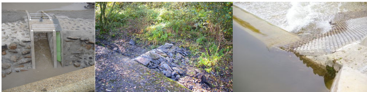
Figure 12 : Aménagements proposés pour la restauration des voies de migration chez l'Anguille : goulottes, pré-barrages et aménagement de rive (de gauche à droite) (Fish-Pass)
