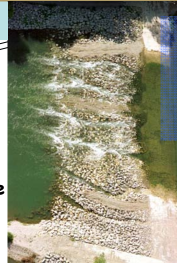
Seuil de l'Ardèche (1999)
