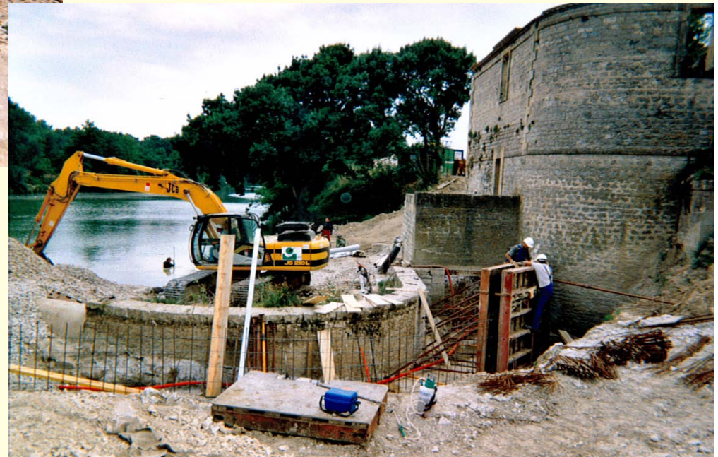
Passe vue amont
