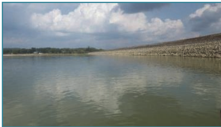
Retenue de Villegusien (Vingeanne) le 09/09/14
