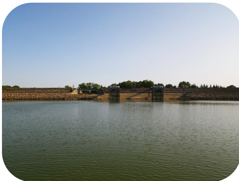
Retenue de Villegusien (Vingeanne) le 14/09/20 (quatrième campagne)
