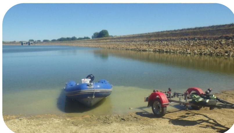
Retenue de Villegusien (Vingeanne) le 27/07/20 (troisième campagne)
