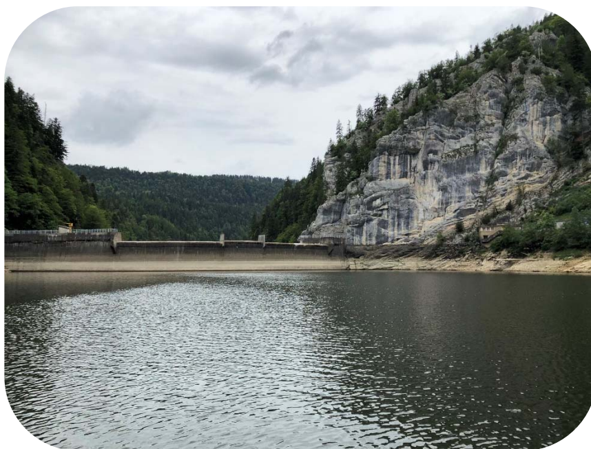
Retenue du Châtelot le 01/06/22
