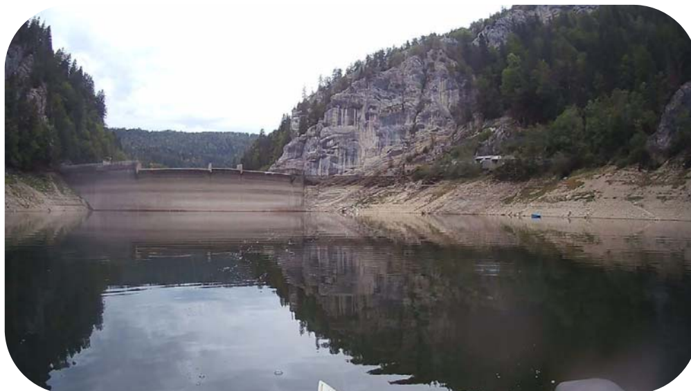
Retenue du Châtelot le 14/09/22
