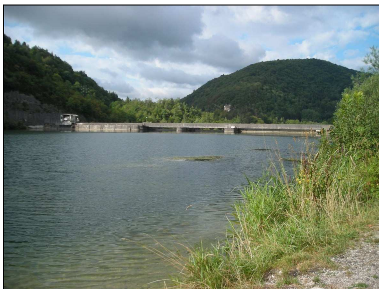
photo 2 : vue prise lors de la reconnaissance hydromorphologique (vue sur le barrage)
