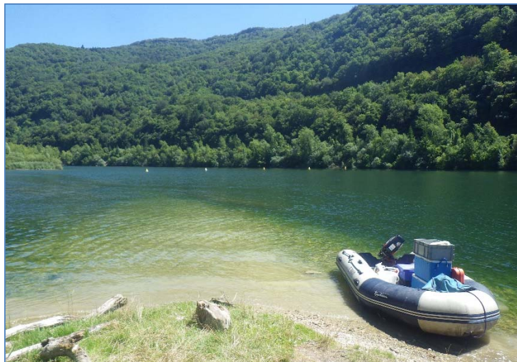
Retenue de Coiselet, le 19/07/2016.
