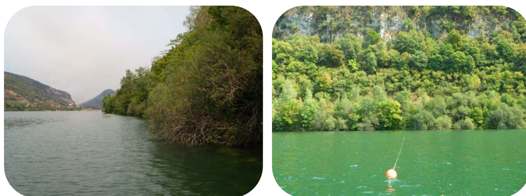
Figure 15 – Unité d'observation 3 sur la retenue de Coiselet, le 10/08/2022.
