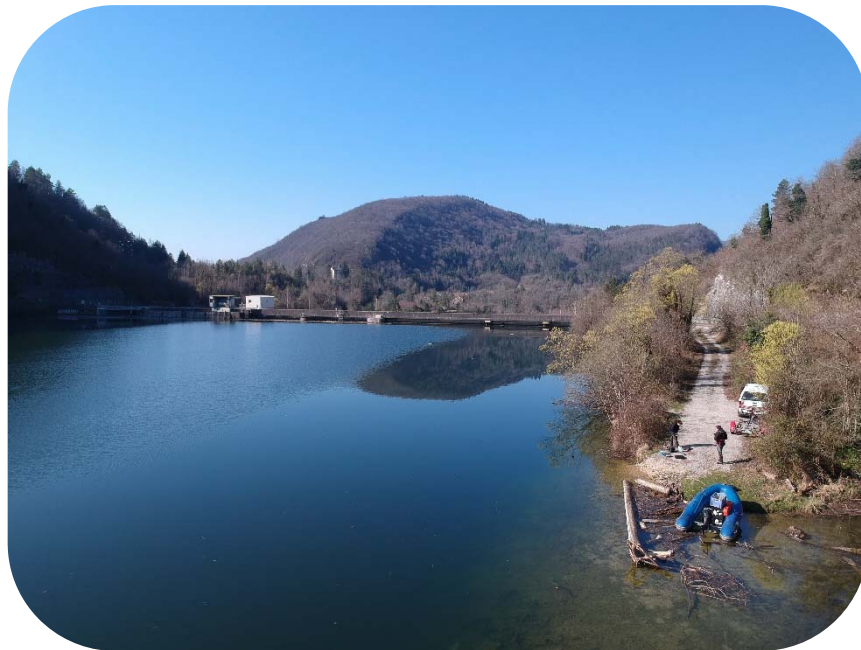
Retenue de Coiselet, le 23/03/2022
