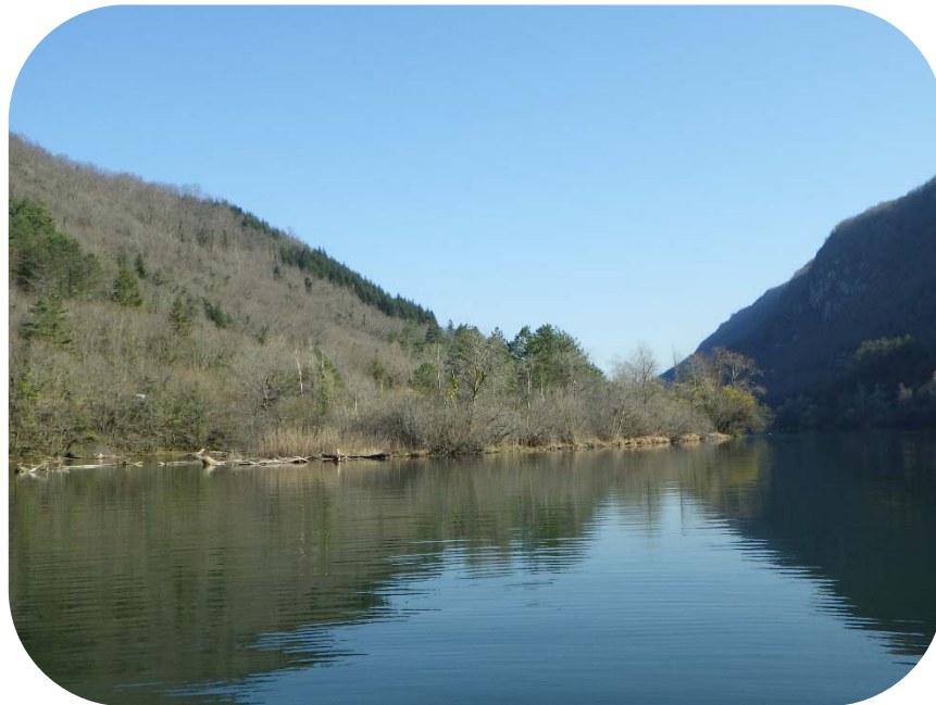
Retenue de Coiselet (01), le 23/03/2022
