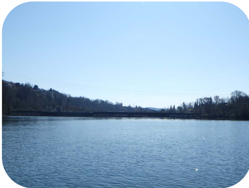
Retenue d'Allement, le 23/03/2022
