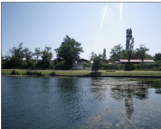
Photo 4 : Vue sur l'UO3 du réservoir du Grand-Large
