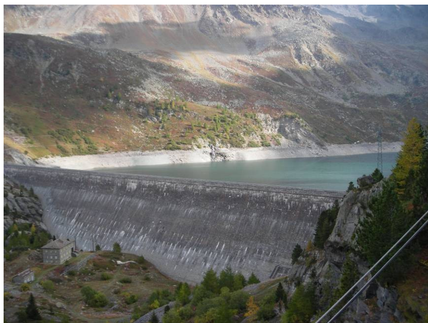
Figure 10 : vues générales sur la retenue
