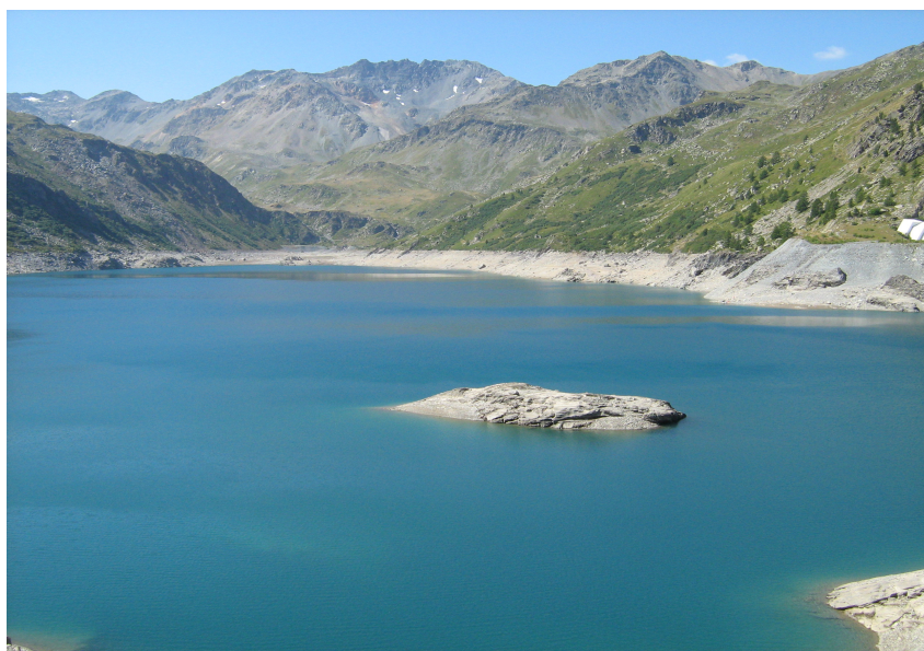
Photo du site : depuis le barrage.
