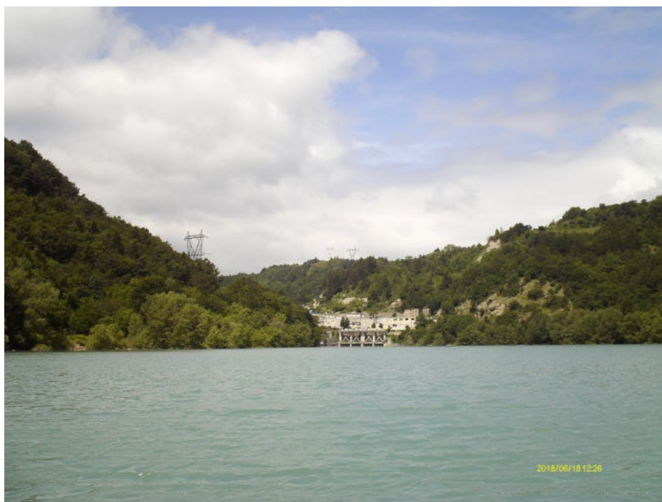
Retenue du Sautet (crédit photo : STE, 2018)
