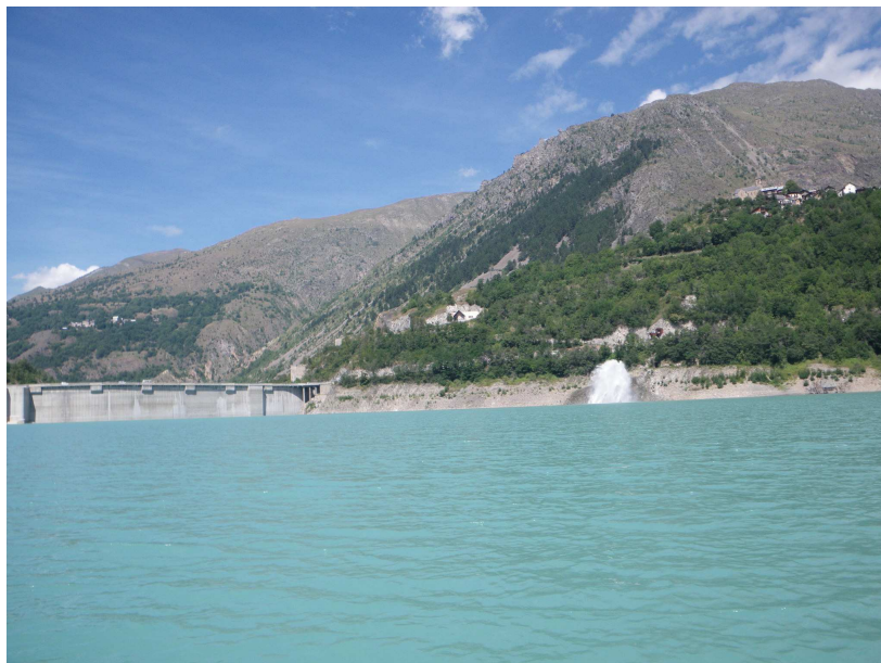
photo 2 : vue sur la barrage et la rive droite depuis la zone de plus grande profondeur
